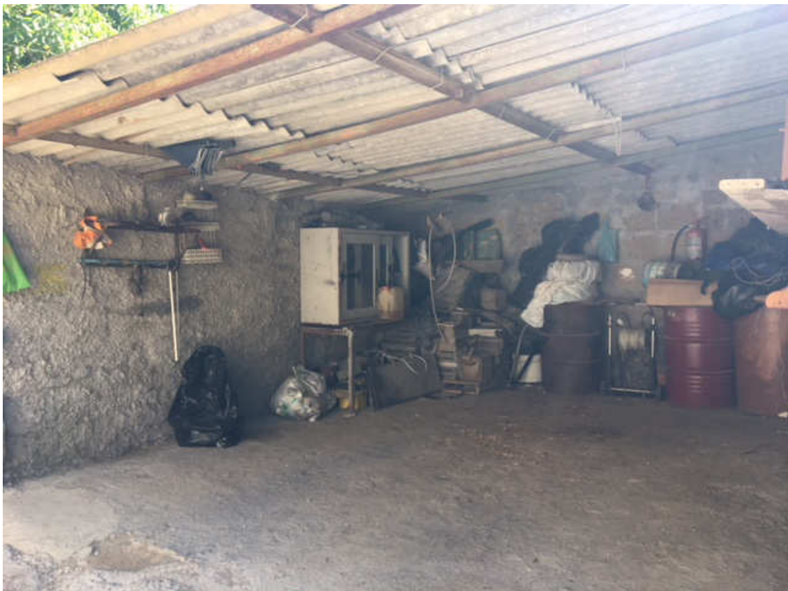
Foto n. 21 – Rimessa attrezzi - interno
