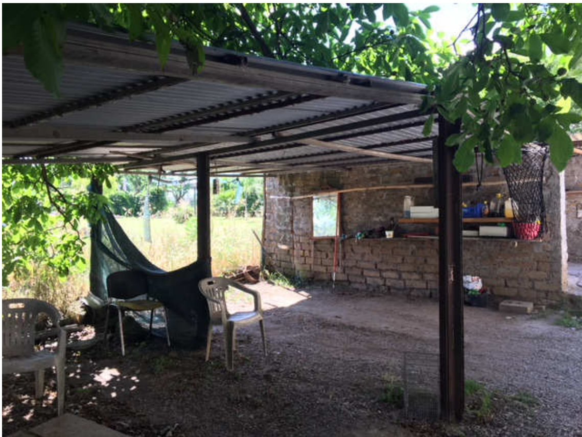
Foto n. 23 – Tettoia metallica realizzata in aderenza alla rimessa attrezzi
