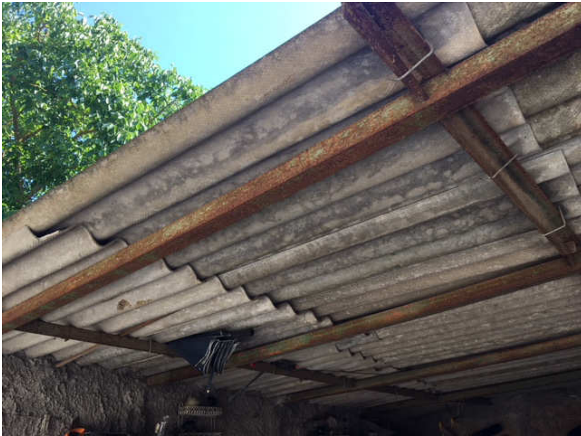
Foto n. 22 – Rimessa attrezzi - copertura
