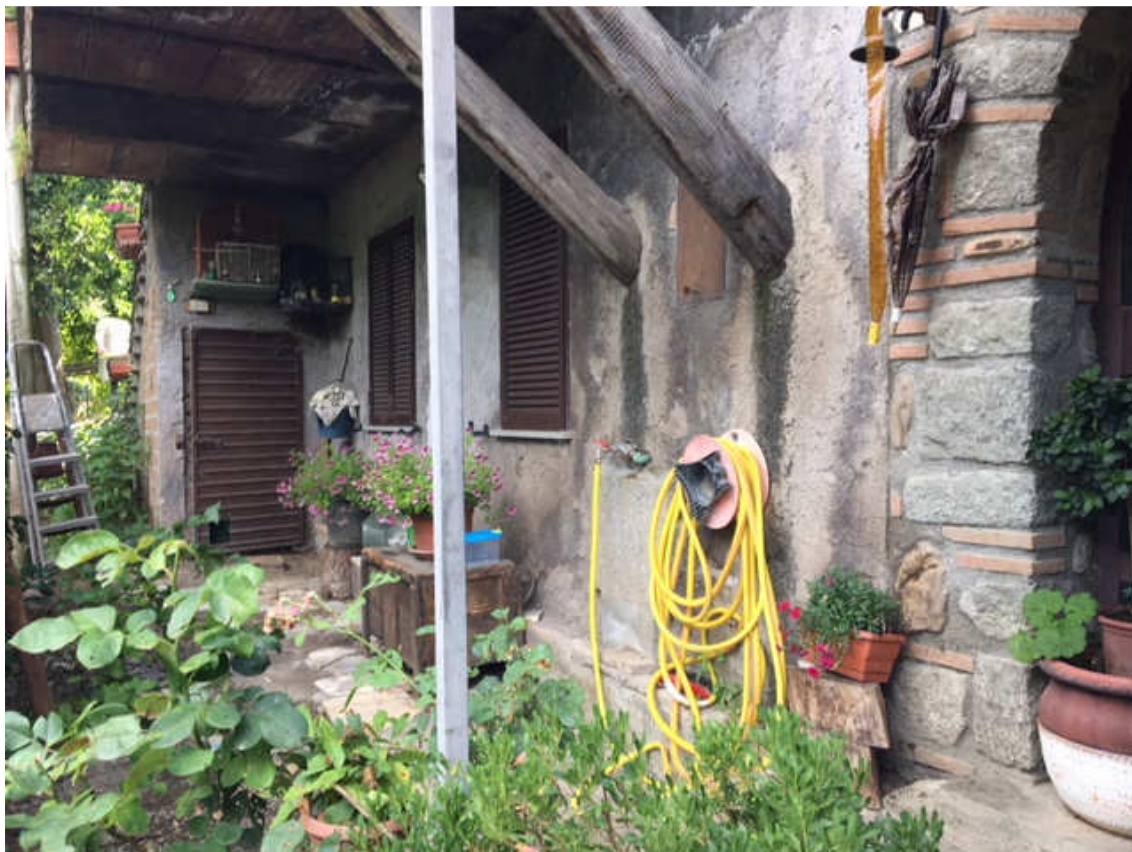
Foto n. 14 – Appartamento PT- esterno
